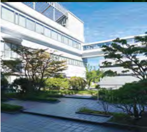
広々とした緑豊かな環境の中で、研究が進められている。研究棟内の計算機室の拡充とともに、敷地内には、新たに計算機棟が増設された。
